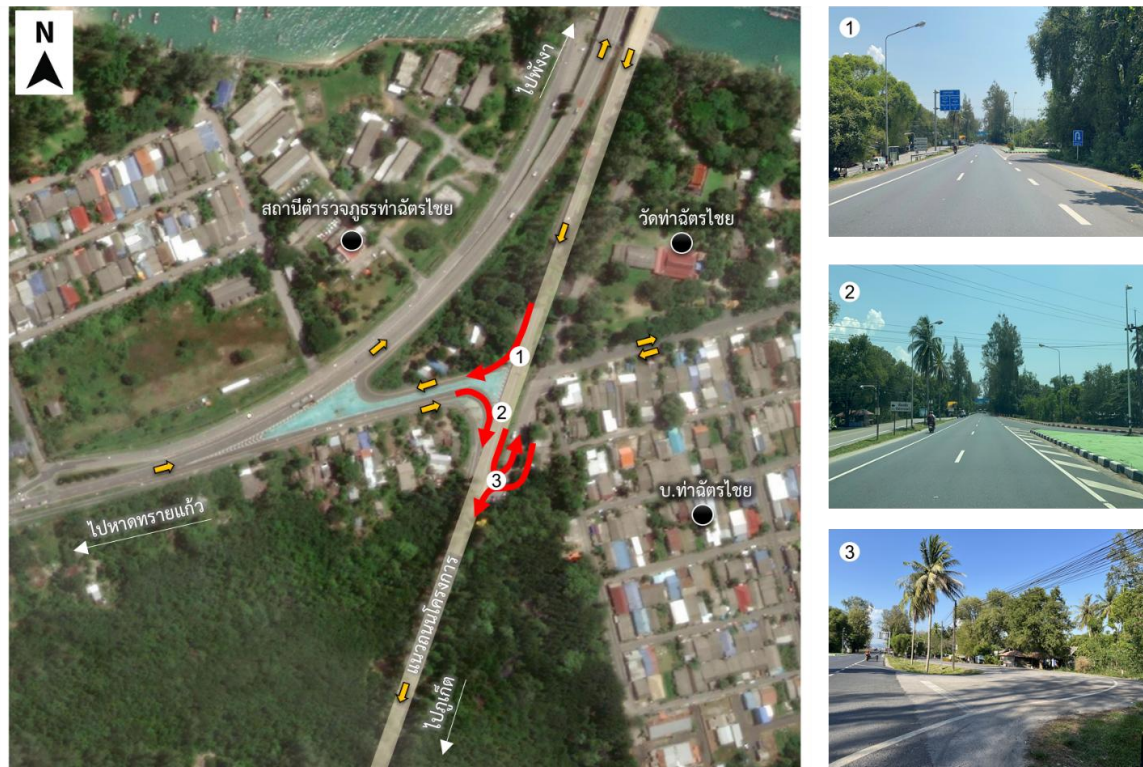
รูปที่ 6-1 แสดงทางแยก (Diverging) พร้อมทางร่วม (Merging) บริเวณจุดเริ่มต้นโครงการ ทางหลวงหมายเลข 402
